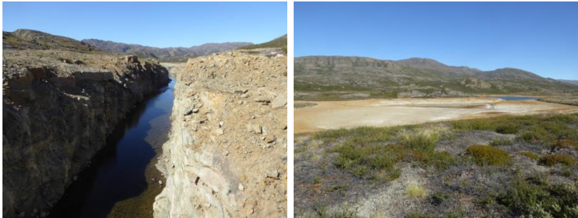
Figur 91. Kanalen mellem søerne Eqalugarniarfiup Tasia og Taseqqat er sprængt i klipperne (tv). Der er en gangbro over kanalen. Kanalen løber via en lavvandet sø (th) ud i Taseqqat, ligesom indløbet fra Eqalugarniarfiup Tasia passerer en mindre sø inden kanalen.
