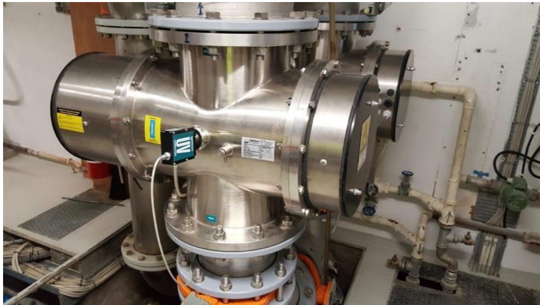
Figur 4-1 UV-aggregat på vandværket i Sisimiut. Dette aggregat er det ene af to på vandværket.
