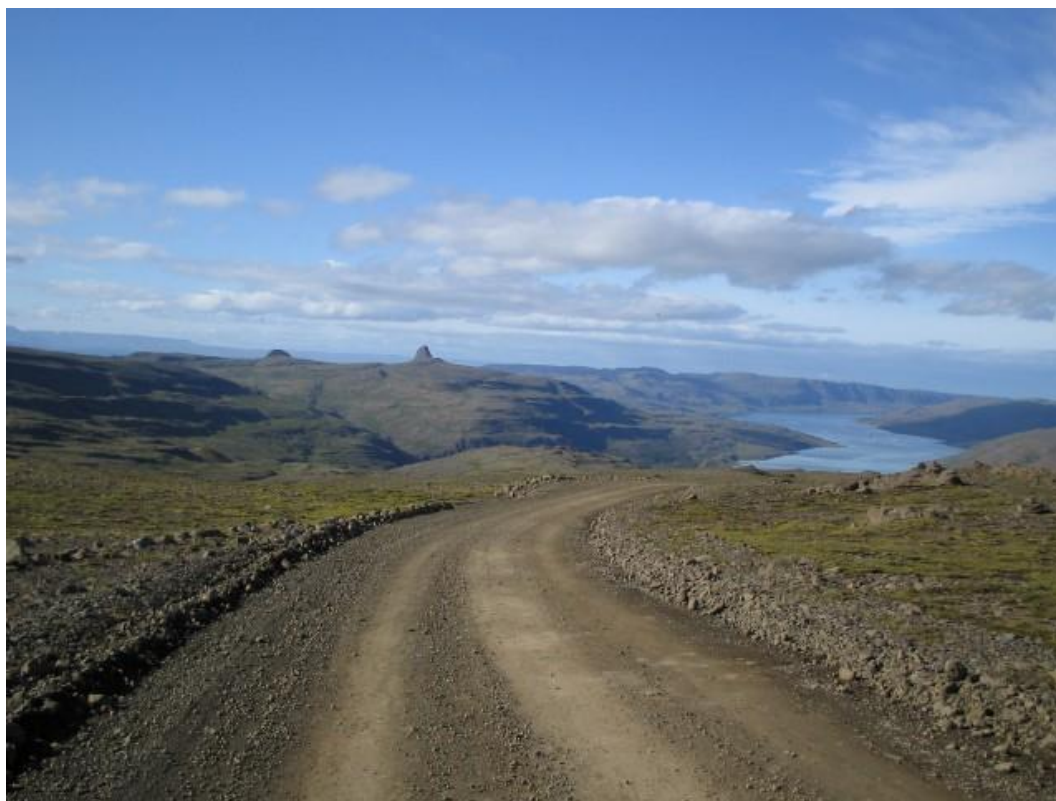
Figur 1.14. Eksempel på en grusvej, som vejen mellem Kangerlussuaq og Kangerluarsuk Tulleq forventes at ville se ud på de strækninger, hvor den ikke kan anlægges på fjeld.
