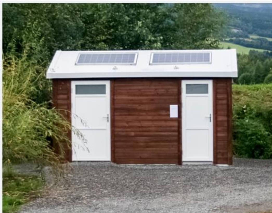
Figur 1.5. Eksempel på en solcelledrevet toiletbygning af en konstruktion, som kunne tænkes anvendt på rasteplasser på vejen fra Kangerlussuaq til Kangerluarsuk Tulleq.
