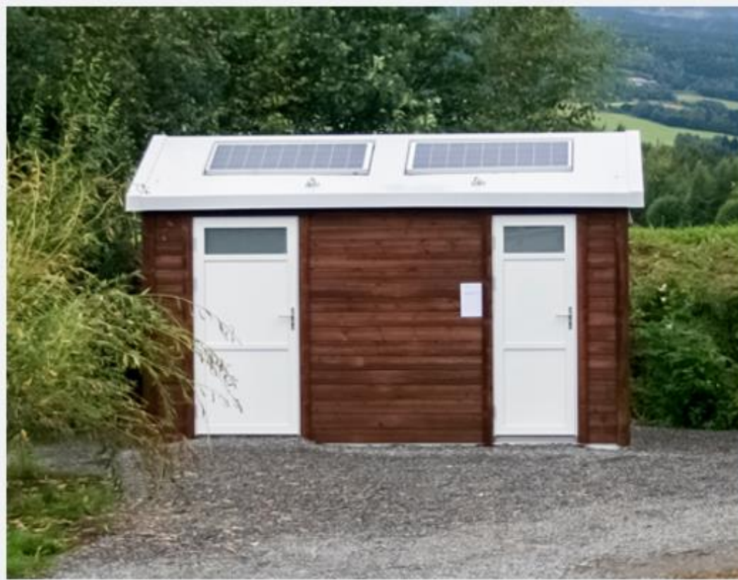
Figur 4.14. Eksempel på en solcelledrevet toiletbygning af en konstruktion, som kunne tænkes anvendt på rastepladser på vejen fra Kangerlussuaq til Kangerluarsuk Tulleq.
