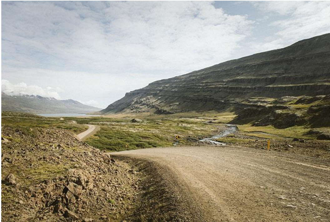
Figur 4.11. Eksempel på en grusvej, som den forventes at ville se ud, når projektet er gennemført. Den viste vej er udformet med en vejkasse, hvilket kun vil være tilfældet på dele af strækningen.
