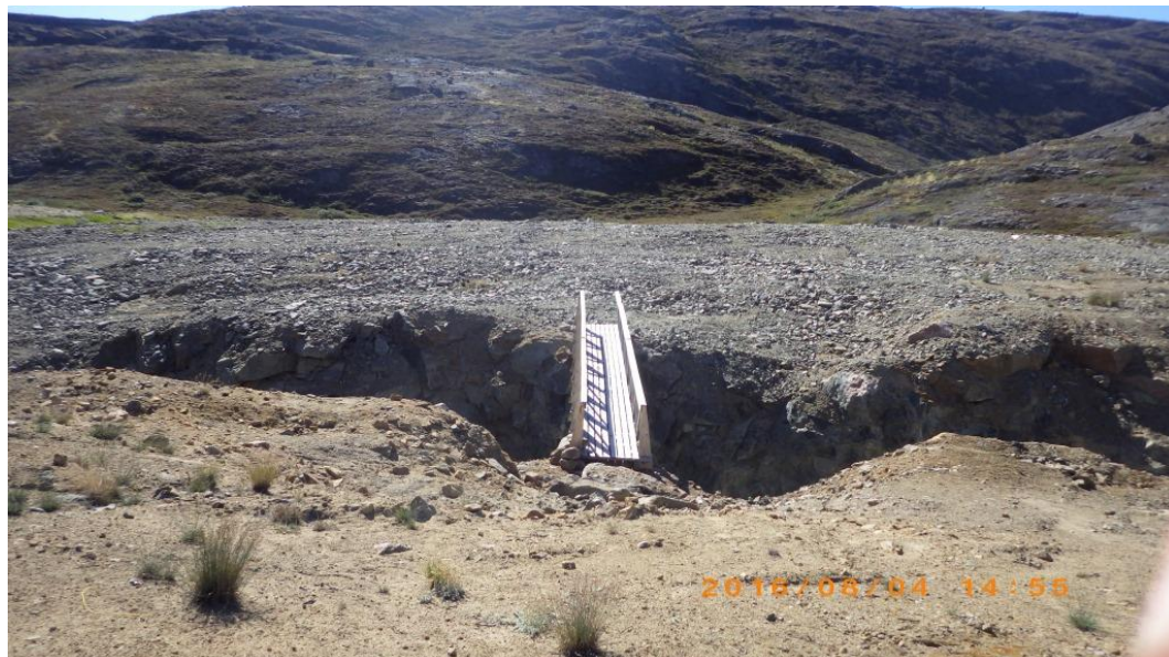
Figur 4.6. Eksempel på en bro af en konstruktion, som kunne tænkes anvendt i projektet. Broen i projektet skal dog være bredere end den, der er vist på figuren, idet den skal kunne betjene ATV'er og biler.
