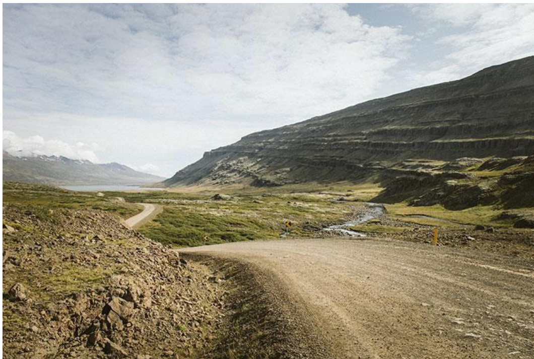
Figur 1-2 Eksempel på en grusvej, som den forventes at ville se ud, når projektet er gennemført. Den viste vej er udformet med en vejkasse, hvilket kun vil være tilfældet på dele af strækningen.
