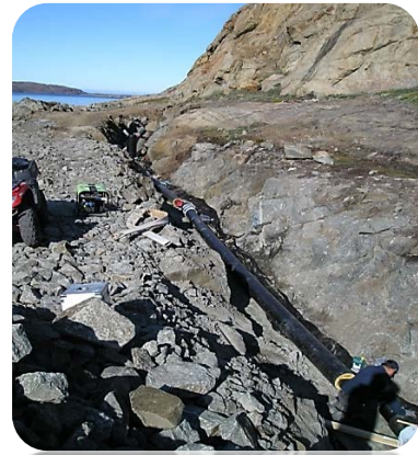
Kloakledning og sti er færdig. Opførelse af nye kollegier kan påbegyndes.
