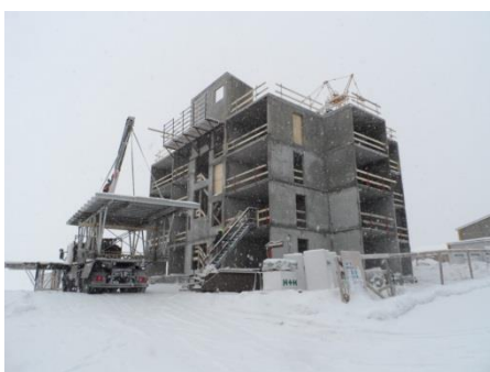
På Deichmanip Aqq. er 16 handicapboliger under opførelse.
