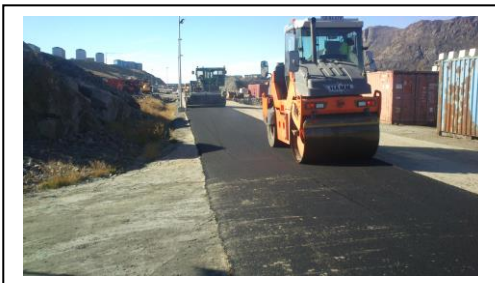
Asfaltering af Ulke bugtvejen
