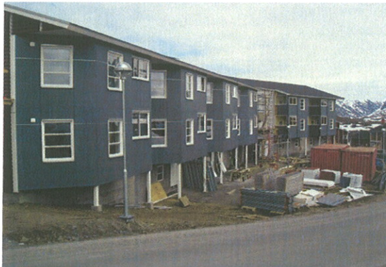
12 ældreboliger ved Niviarsiaq færdiggjort og indflytning i foråret 2013
