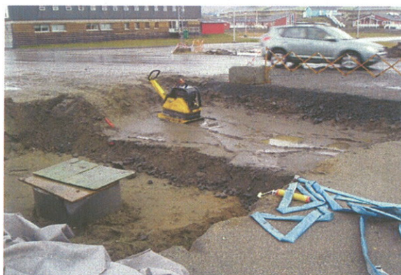
Kloakreivering blev fortsat, bl.a. med ledningsudskiftning under Aqqusinersuaq.
