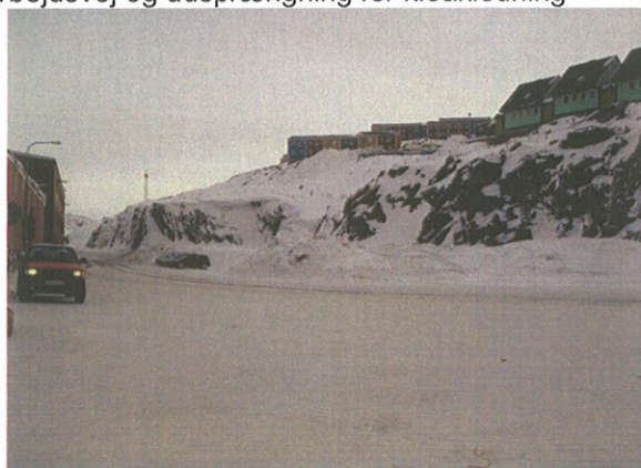
J.M.Jensenip Aqq ved havnepakhus blev afsluttet med grusregulering, evt omlægning af vej afventer KNI's udmelding om nyt indgangsparti til pakhus.
