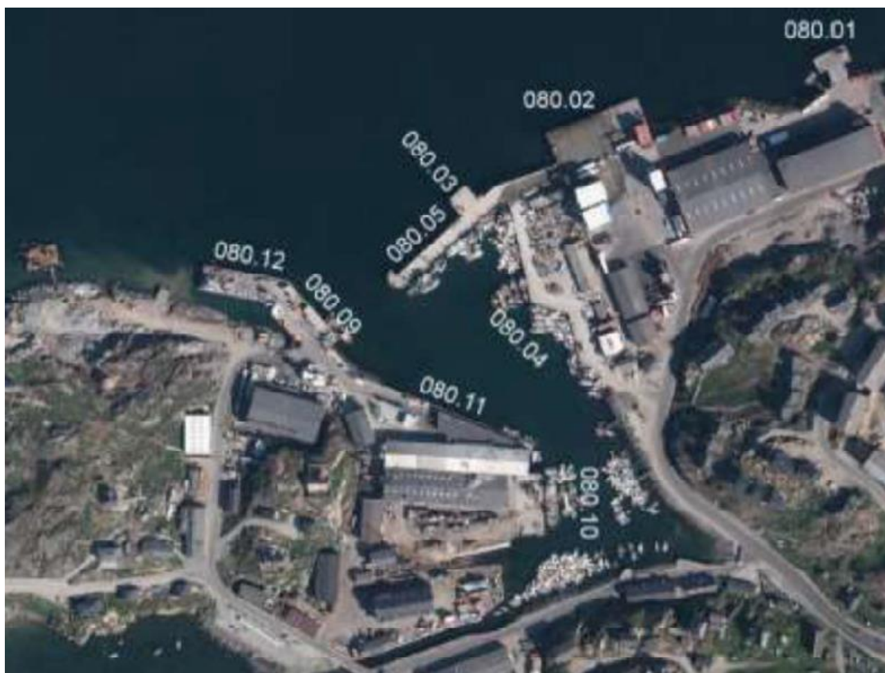
Figuren viser hele havnen (bortset fra den kommunale havn) i Sisimiut, hvor Selvstyrets sektorplan satser blot på at udvikle 3 af havnene, hvor resterende ønskes overdraget:
